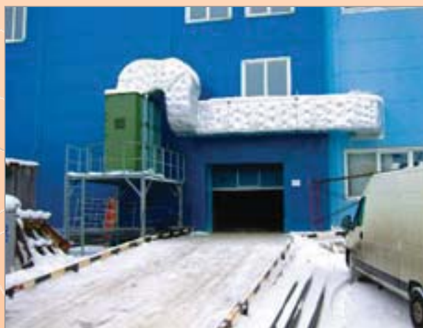
САНКТ-ПЕТЕРБУРГ, ООО «Нева-Катер» (складские помещения)
