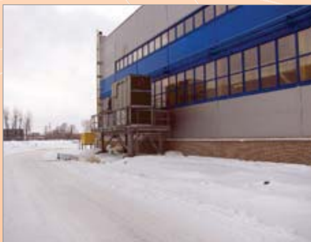
ТУЛА, ЗАО «Сталинвест» (завод по производству теплоизоляционных изделий)
